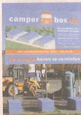
Die Bauarbeiten für die „camper boxen“ haben begonnen.
